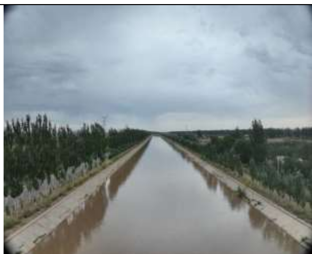
永济北边分干渠土工模袋护坡+植物护堤
