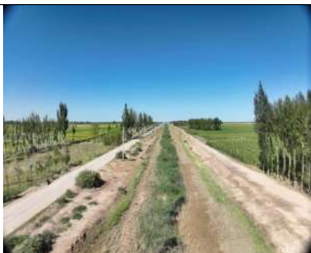
义通排干沟植物护堤
