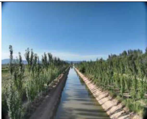
西乐分干渠土工模袋护坡+植物护堤
