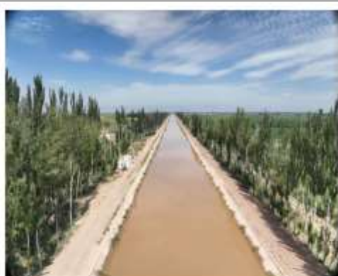
杨家河分干渠土工模袋护坡+生物护堤 (2024.7.31)
