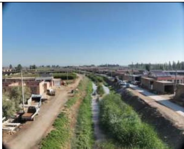
四排干沟植物护堤
