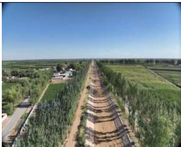
永兰分干渠土工模袋护坡+植物护堤
