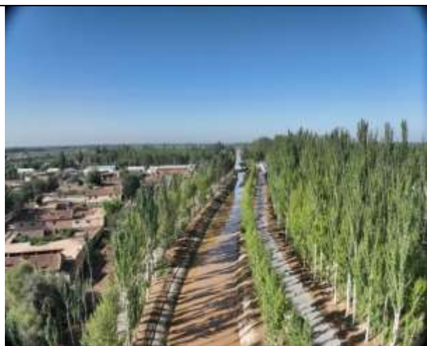
合济分干渠土工模袋护坡+植物护堤
