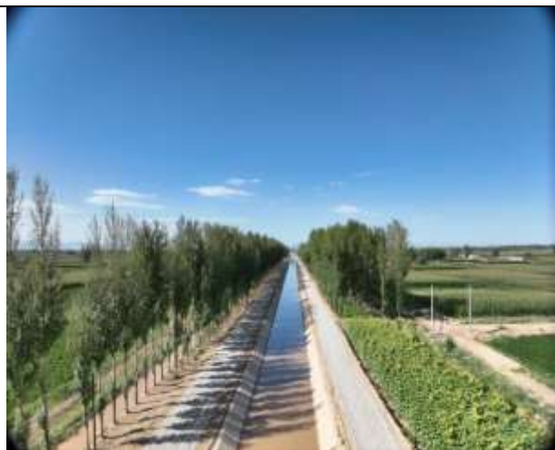
西乐西稍分干渠土工模袋护坡+植物护堤
