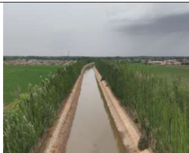
沈乌干渠土工模袋护坡+植物护堤
