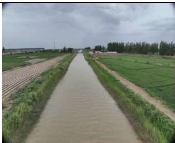
乌拉河干渠植物护堤
