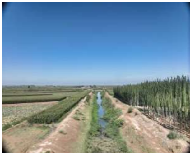
三排干沟植物护堤
