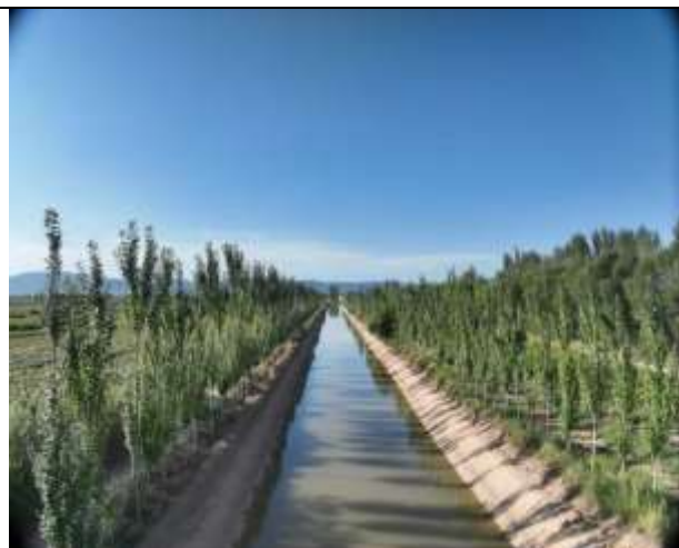
西乐分干渠土工模袋护坡+植物护堤
