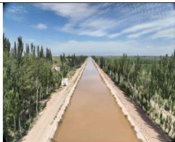
杨家河干渠土工模袋护坡+植物护堤
