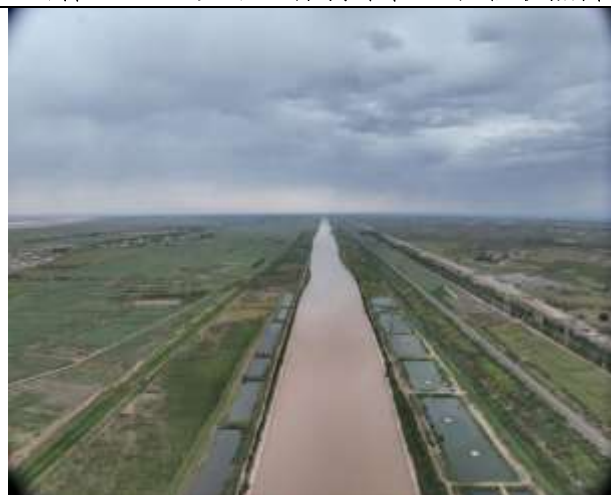
总干渠土工模袋护坡+植物护堤
