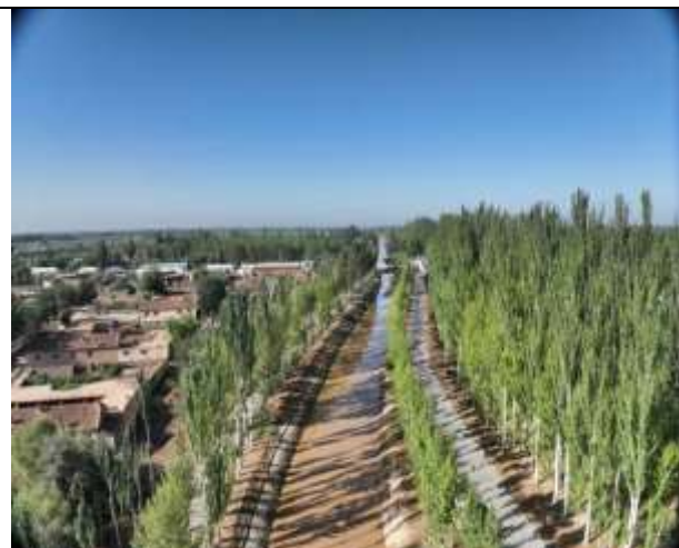
合济分干渠土工模袋护坡+植物护堤
