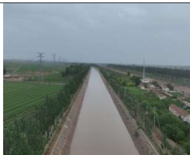
永济干渠土工模袋护坡+植物护堤
