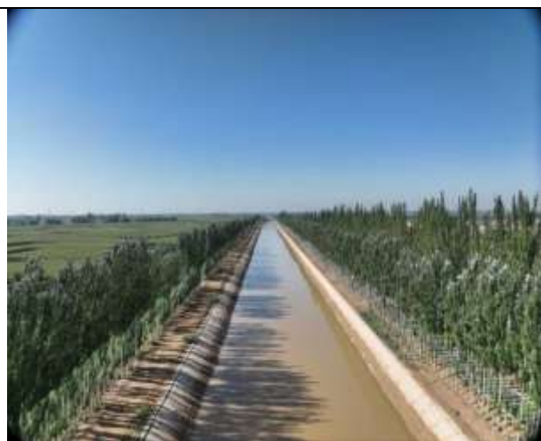
黄济干渠土工模袋护坡+植物护堤
