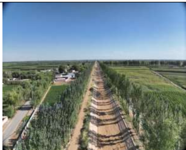
永兰分干渠土工模袋护坡+植物护堤
